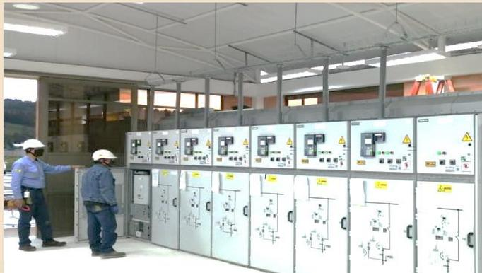
Subestación Tundama 34.5/13.8 kV
